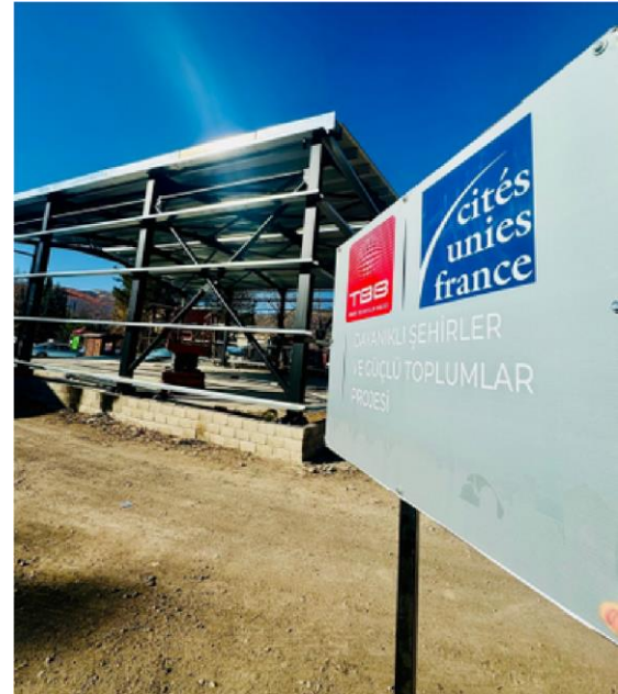
Nouvel Hangar de stockage
