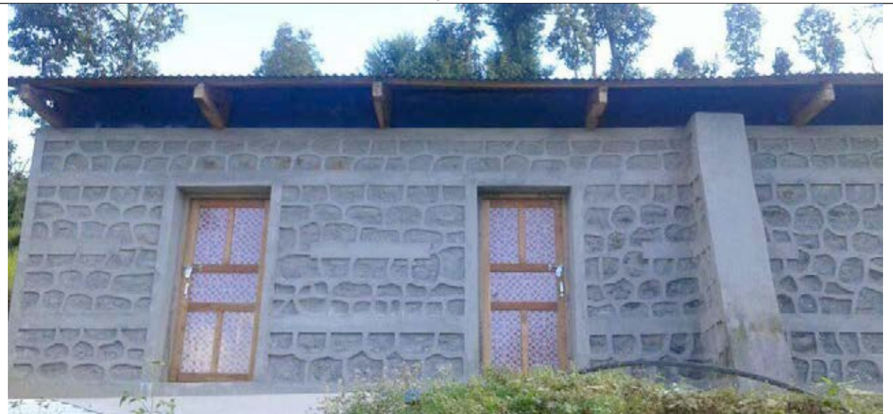
Le bâtiment terminé
