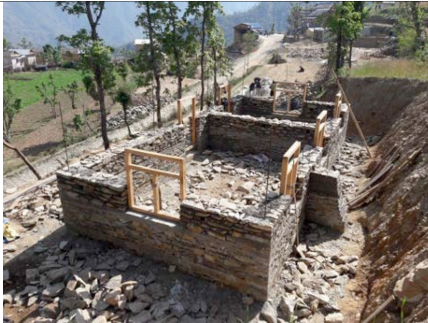
Pose de fenêtres
