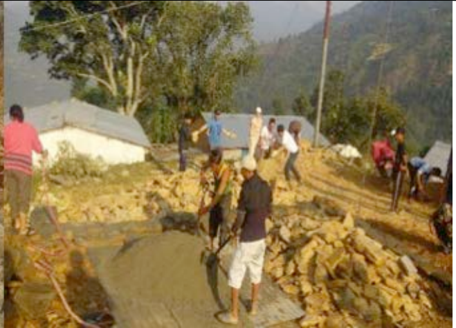
Montage du mur en pierre
