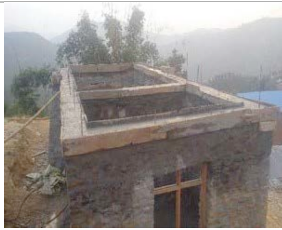
Coffrage du chainage périphérique
