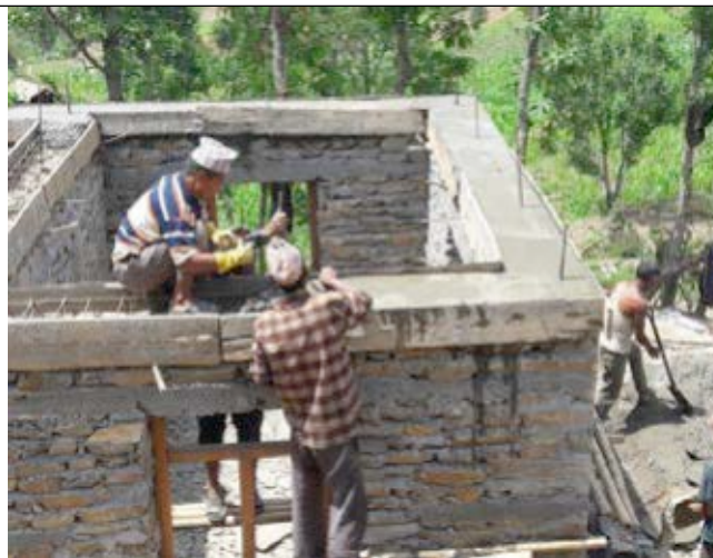
Ceinturage par chaînage périphérique
