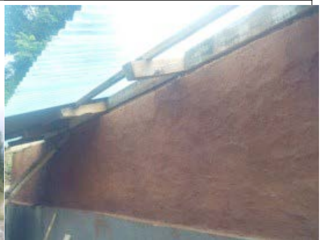
Enduit de finition
