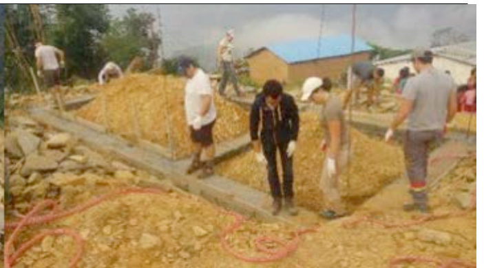
Décoffrage du chainage bas, barrière d'étanchéité
