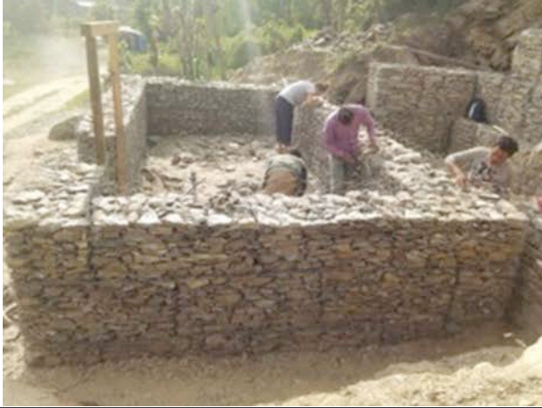
Elévation du mur de pierres confinées
