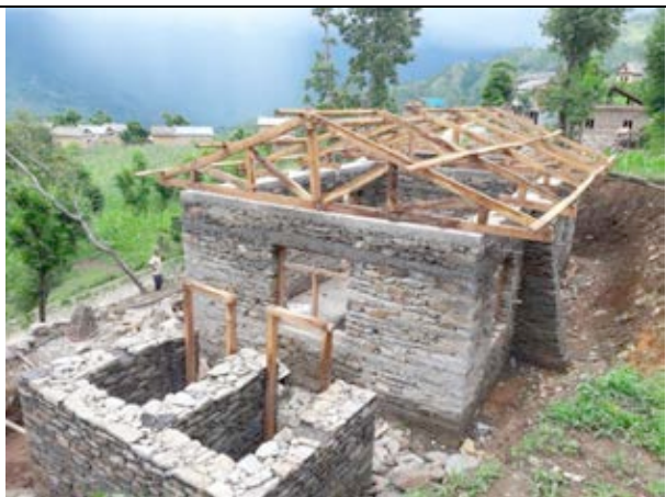
Découpe et pose de la charpente
