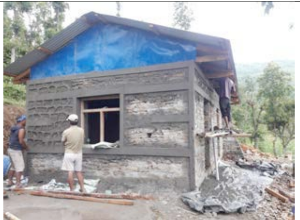
Pose de la couverture de tôles et du parement de pignon
