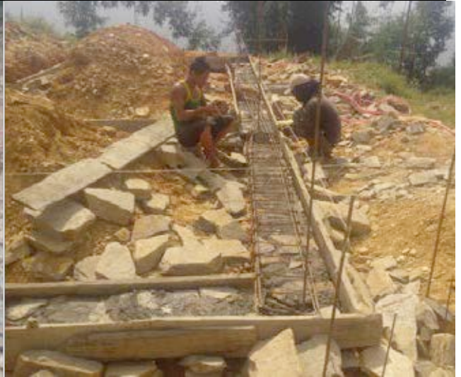
Lit de pierres en fond de fouilles, chainage
