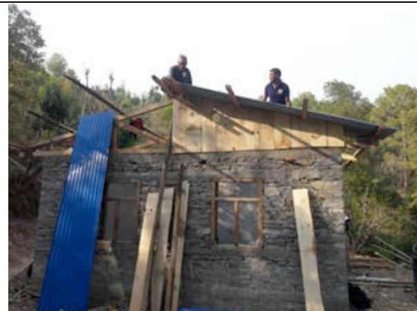
Accroche de la charpente sur le mur, pose de la toiture et couverture en tôle
