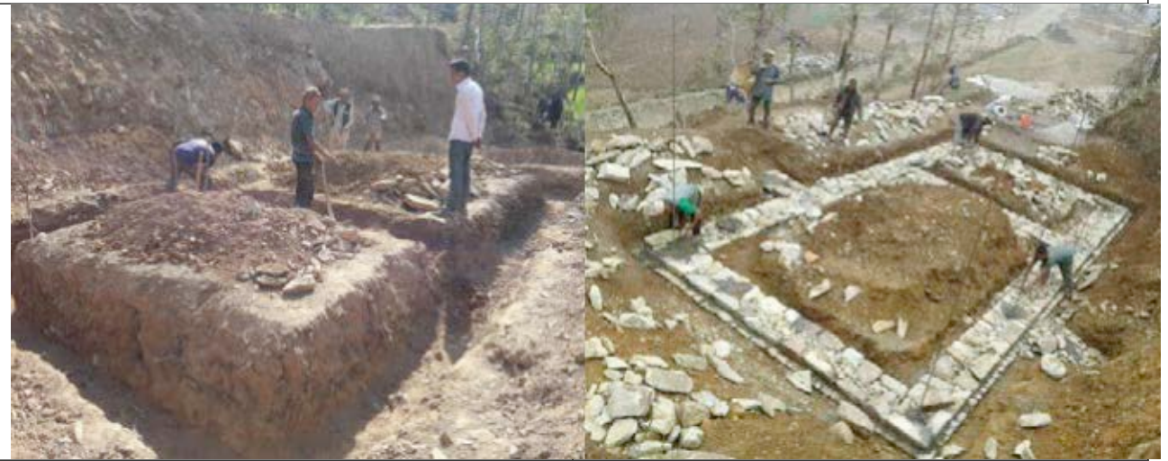
Fouilles, lit de fondation, soubassement avec chaînage
