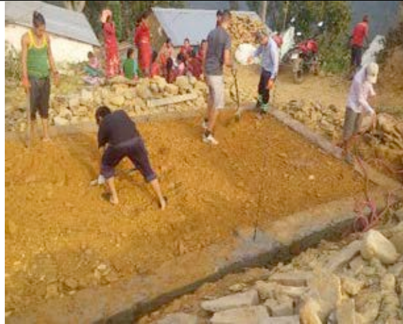
Remblai et mise à niveau
