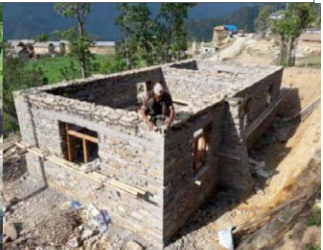
Ceinturage par chaînage périphérique
