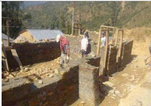
Contreforts en facce
