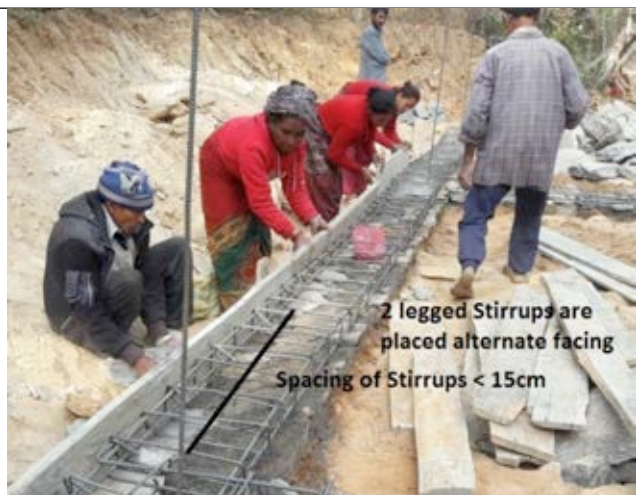
Chainage en béton armé
