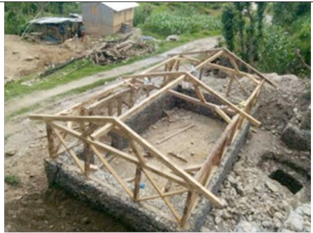
Pose de la charpente
