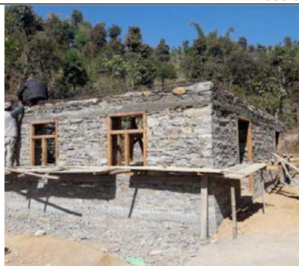
Chainage au niveau des linteaux et renforcement en angle
