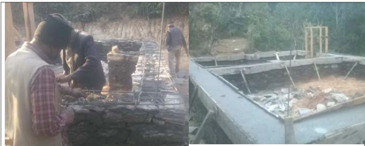
Chainage intermédiaire au niveau de l'allège
