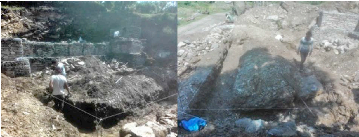
Fouilles et fondations
