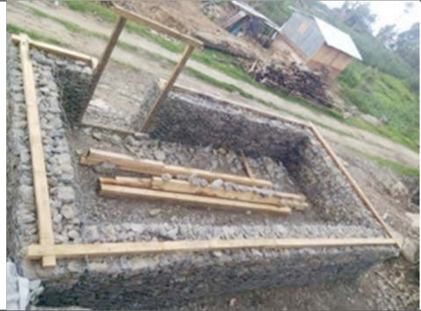
Pose de la structure supérieure en bois
