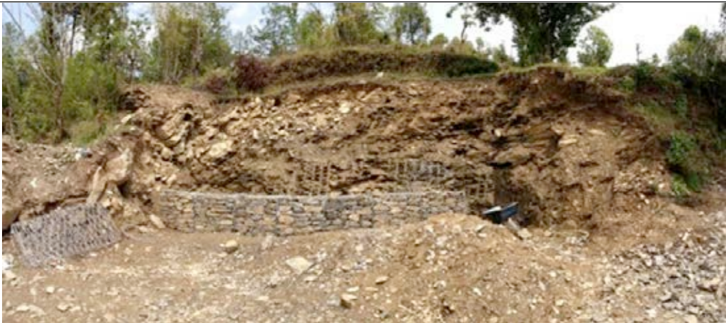
Construction d'un mur de soutènement
