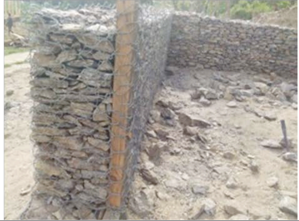
Elévation du mur de pierres confinées
