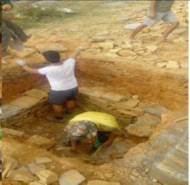
Cloison en pierres sèches pour la fosse
