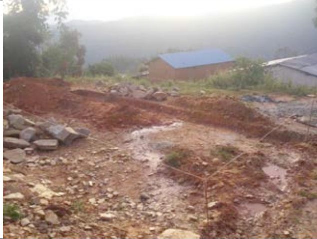
Implantation et excavation
