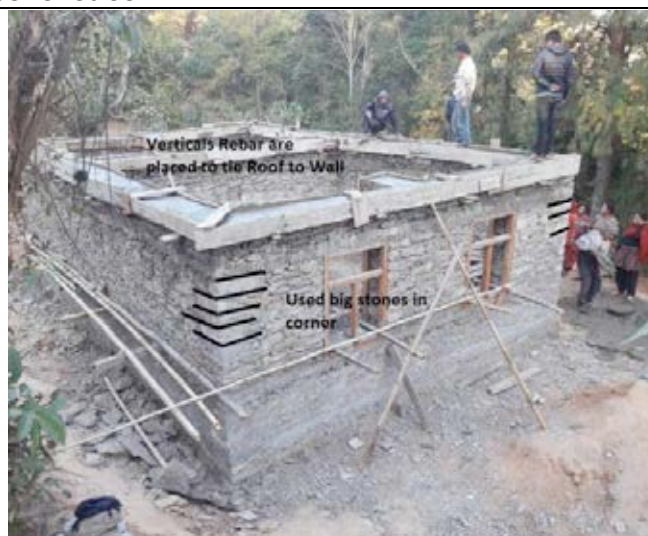
Chainage au niveau des linteaux et renforcement en angle
