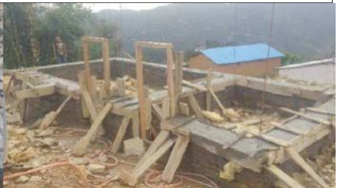
Pose des menuiseries
