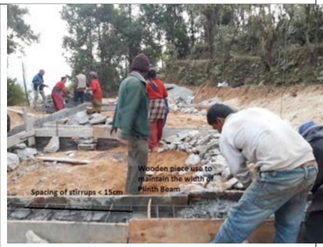
Chainage en béton armé
