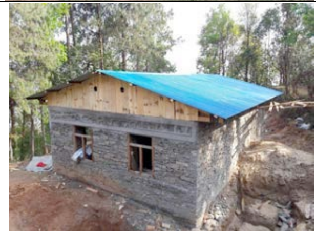
Accroche de la charpente sur le mur, pose de la toiture et couverture en tôle
