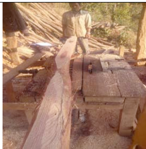
Débit des planches sur place
