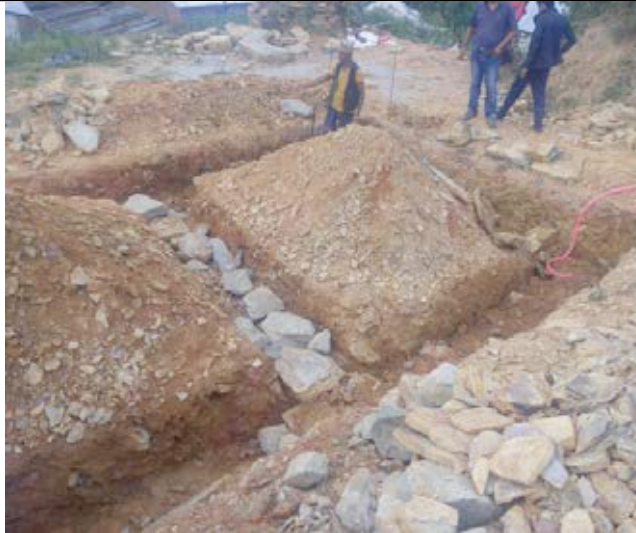
Lit de pierres en fond de fouilles, chainage
