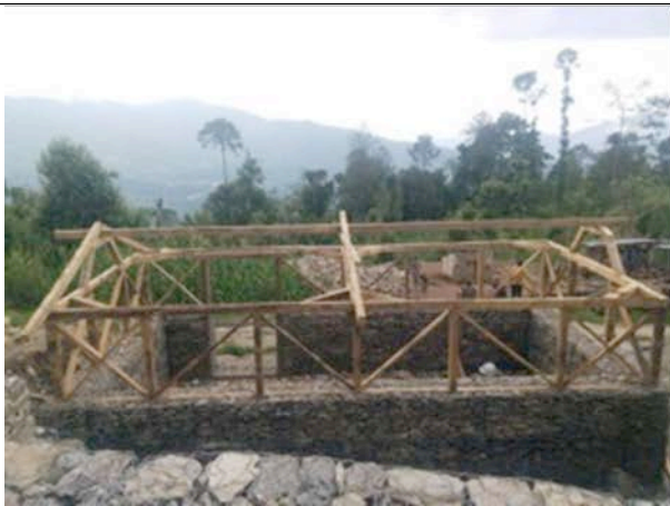
Pose de la charpente
