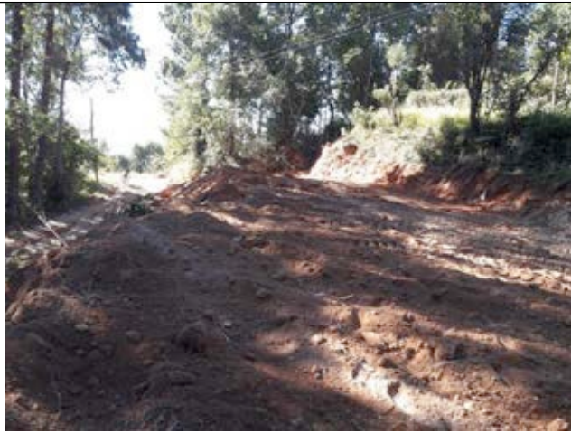
Excavation et fouilles
