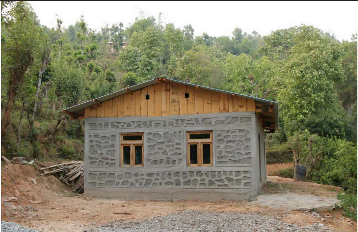
Le bâtiment terminé
