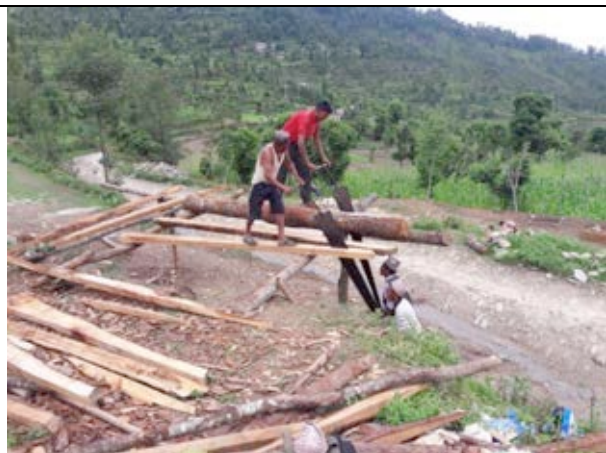
Découpe et pose de la charpente
