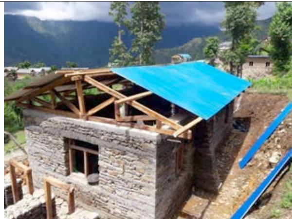
Pose de la couverture de tôles et du parement de pignon
