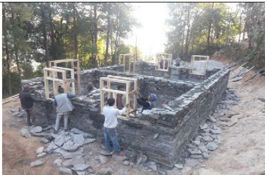
Pose des fenêtres
