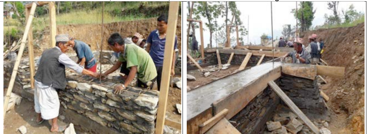
Renforcement par chaînage au niveau des allèges
